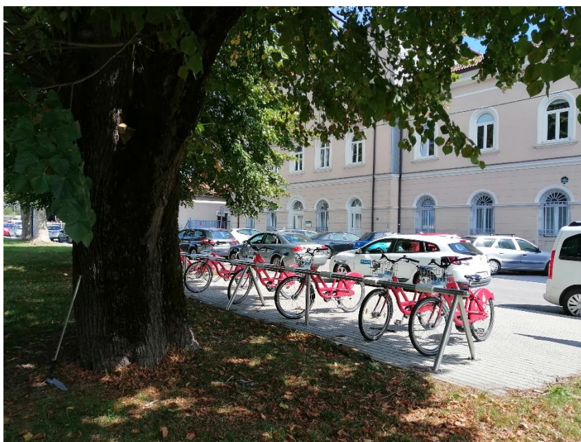
Fotografija 1: Novo parkirišče/postajališče za kolesa na Kolodvorski cesti je poškodovalo koreninski sistem stare lipe.
